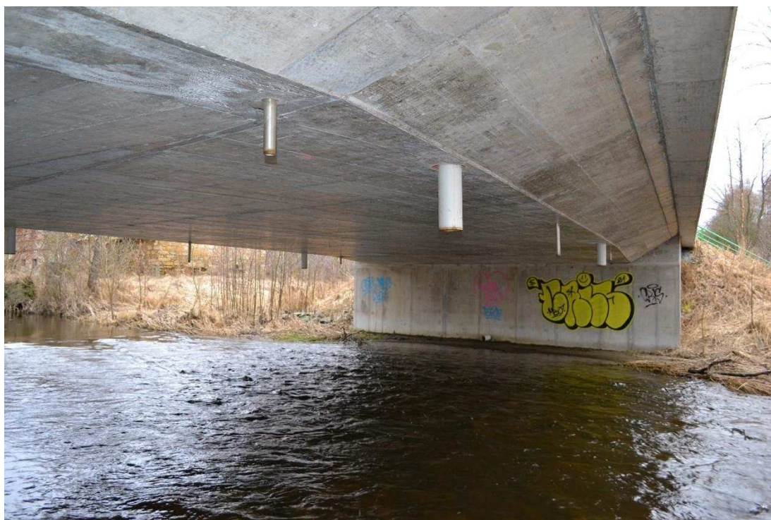
Obr. 7 a 8. Typický nevhodný most – hladká betonová konstrukce, bez jakýchkoliv odsedávek – slangově „kostka“. Zároveň ukázka správného provedení fotodokumentace – celkový pohled + detail spodní strany. Hamerský potok u Červeného mlýna, Planá [TC] . Foto Martin Liška.
