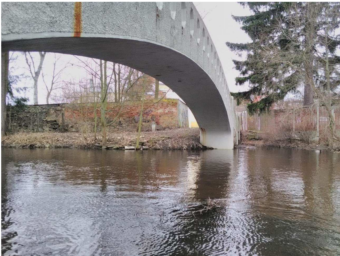
Obr. 9. Nevhodný most – krom hladké konstrukce vadí také malá šířka (2 m), ani odsedávky by nepomohly. Mže, lávka mezi Chodskou ul. a tř. Míru, Tachov [TC] . Foto Martin Liška.
