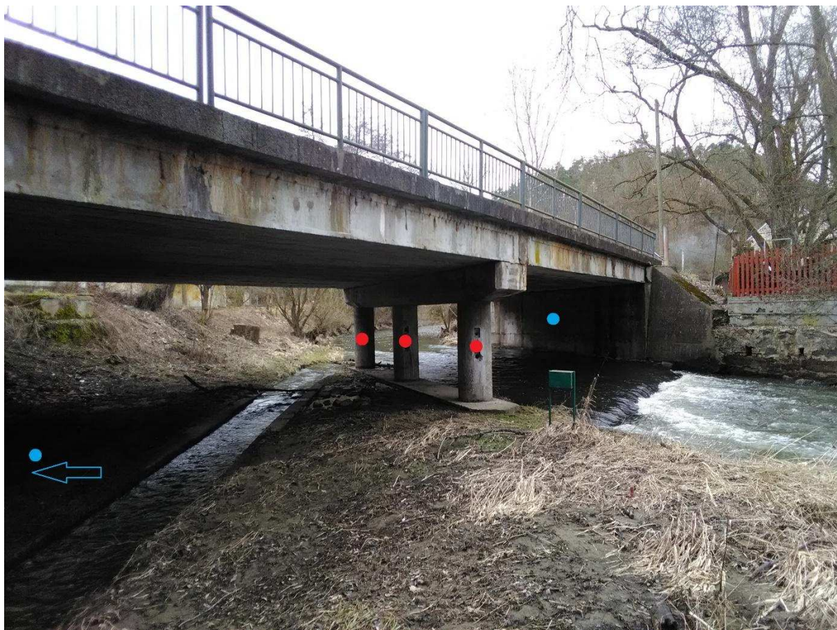
Obr. 2. Ukázka správného zápisu počtu mostních pilířů a opěr (vysvětlivky viz výše). Úhlavka, most u soutoku se Mží, Stříbro [TC] . Foto Martin Liška.
